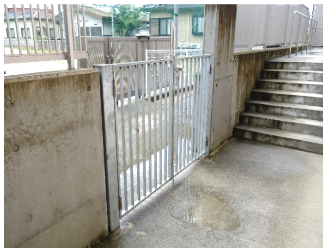
ドアを出てスロープを下りたドア
